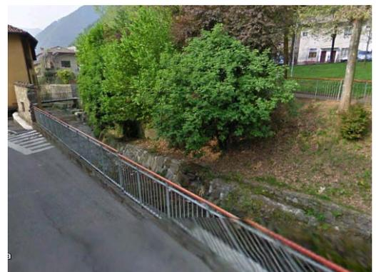
**Fig.2:** Vista del tratto di muro d'argine da innalzare dalla strada in sx idrografica
