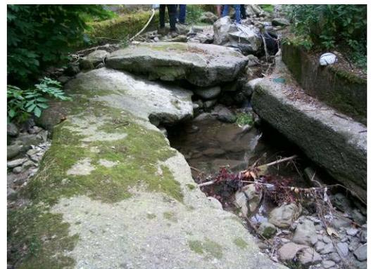
**Fig 2: Particolare dell'erosione al piede**
